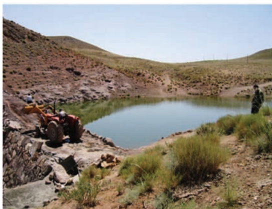
شکل ۴-۱۸- یک آبخوان احداثی در مرتع
